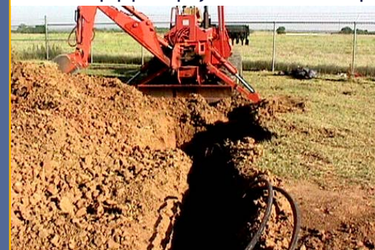
Εκσκαφή για οριζόντιο εναλλάκτη
