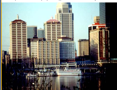
Κτιριακό συγκρότημα, Kentucky, ΗΠΑ
